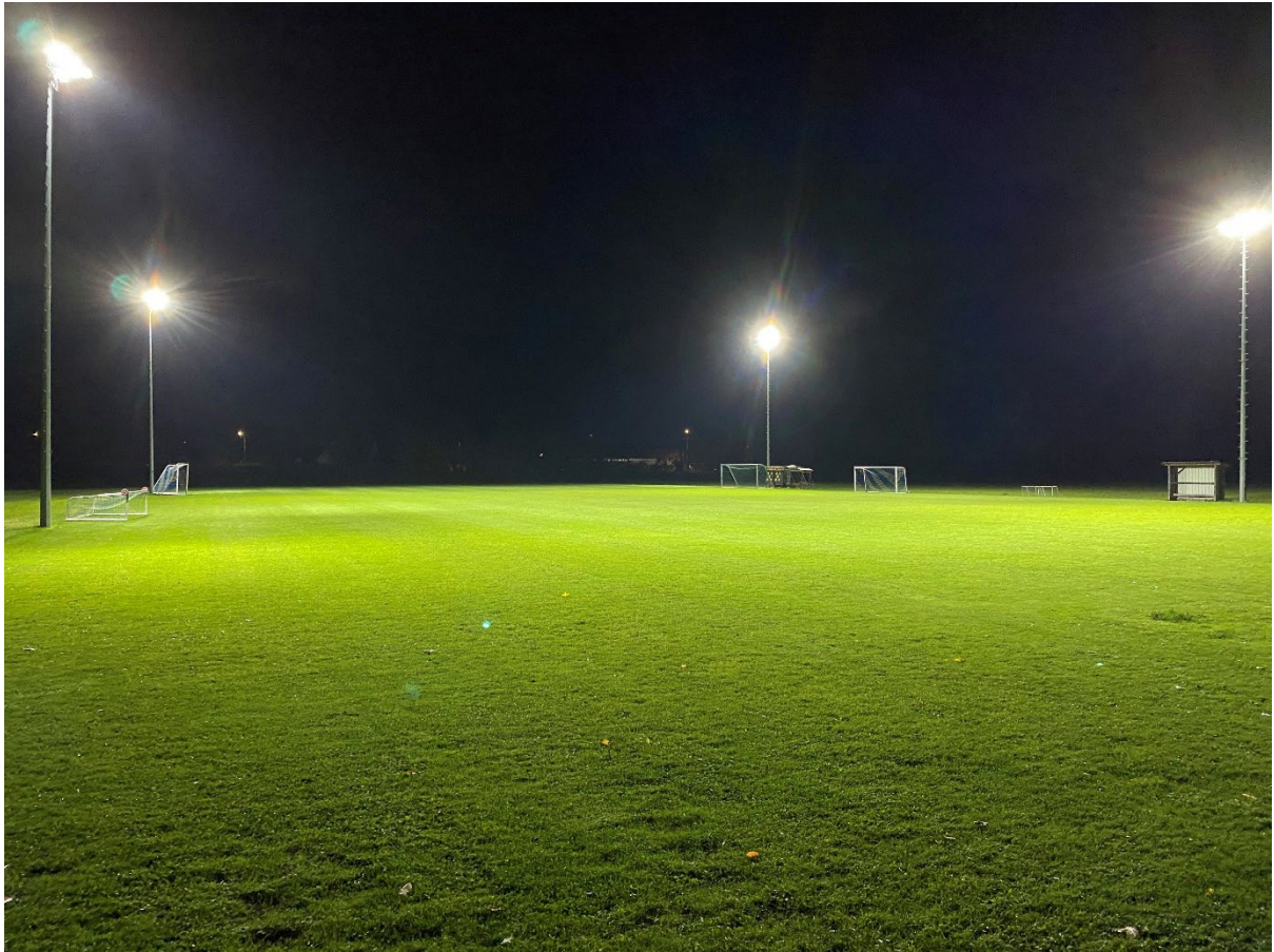
Der Trainingsplatz des ASV Hiltenfingen erstrahlt in neuem Licht © Dennis Saatkamp
